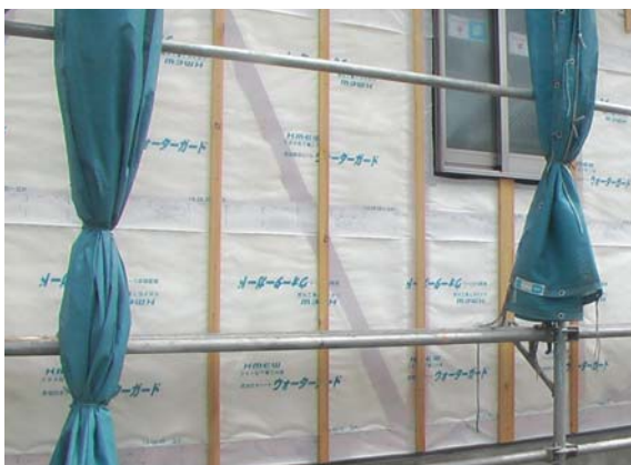
透湿シートへの施工時の外観
